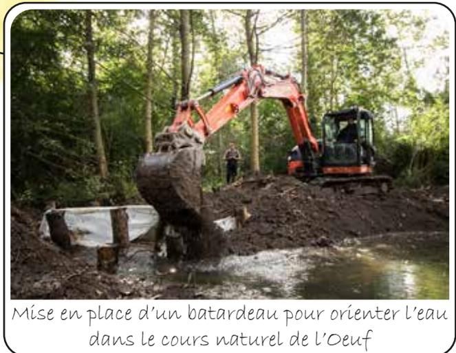
Mise en place d'un batardeau pour orienter l'eau dans le cours naturel de l'Oeuf
