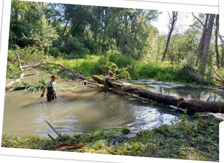
◀ **Gestion des embâcles** au niveau des ouvrages et des arbres tombés pour garantir l'écoulement des eaux, le bon état des milieux aquatiques et prévenir les inondations, qui est réalisée au quotidien par l'entreprise d'insertion.
