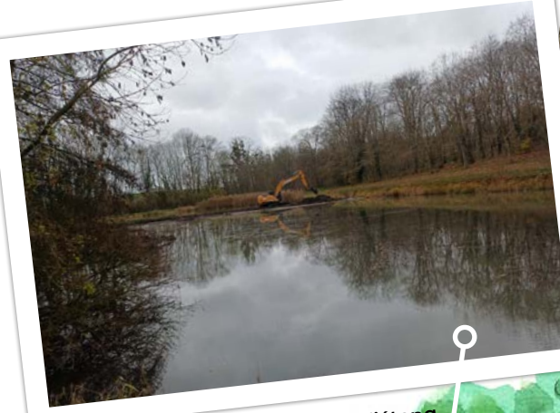
▲ Restauration d'une partie de l'étang communal en zone humide
