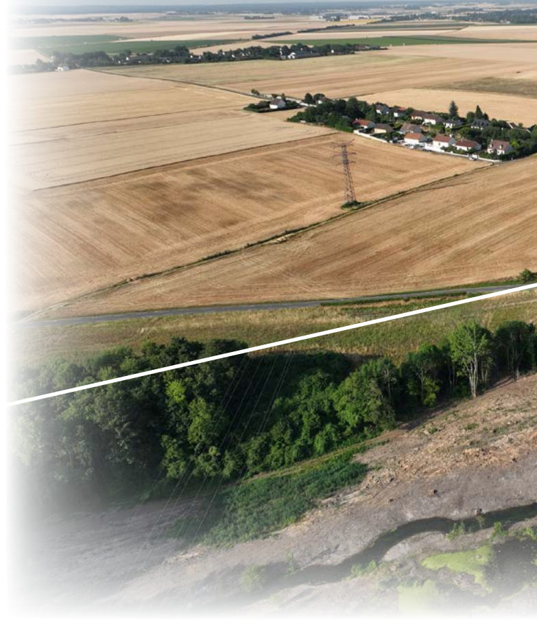
▲ Vue générale du chantier de restauration de l'Œuf
